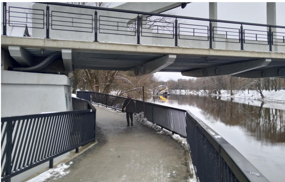
Foto 31. Jõe kohale ehitatud läbipääs Tartu Kaarsilla alt.
